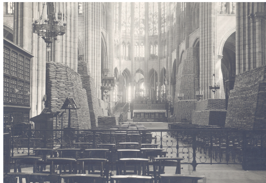
Figure 12 : Archive en ligne de la ville de Saint-Denis, Basilique Saint-Denis, protection contre les bombardements, 1940.
